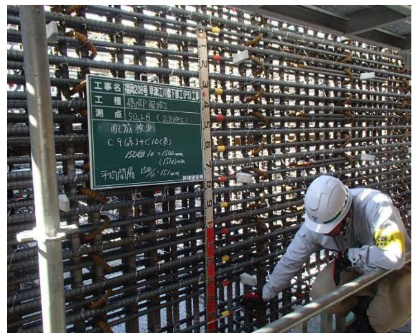
写真-1 従来の鉄筋検査(自主検査)
