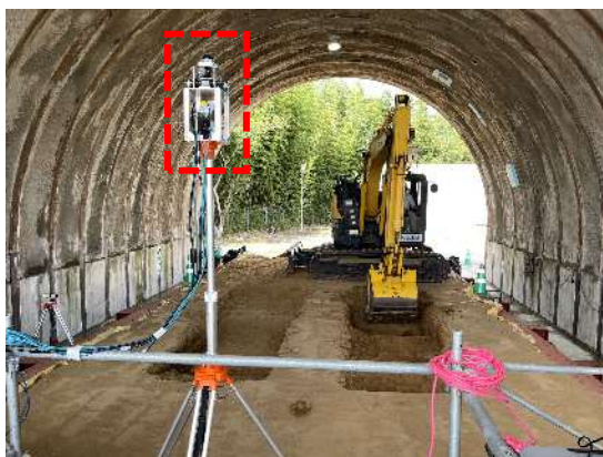
現地に設置した撮影カメラと可搬式 LiDAR が一体となった装置（点線部）
