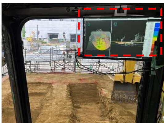
重機コックピット内のモニター（点線部）
