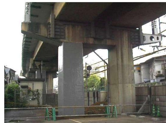
写真－9 施工完了（14P）
