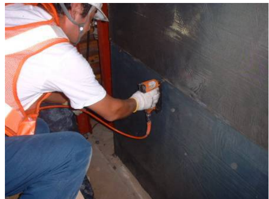
写真－6 エアータッカーによる仮留め
