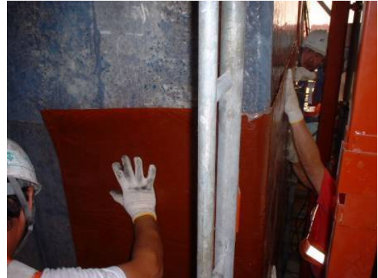
写真－4 耐震補強用シートの貼付け
