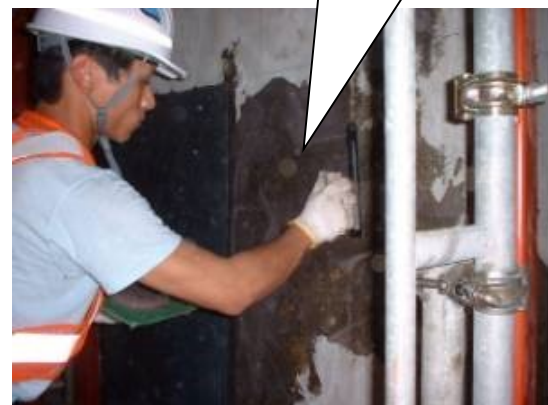
写真－3 プライマーの塗布
