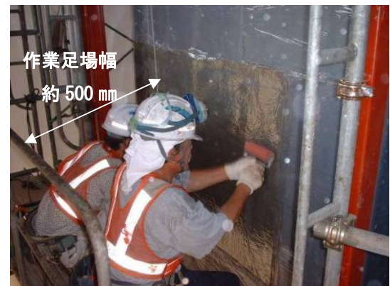
写真－5 狭隘な場所での脱泡作業
