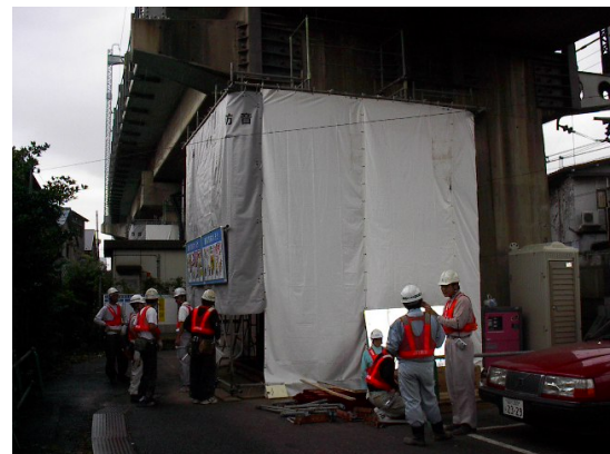
写真－１ 養生シート取付け状況（１４Ｐ）
