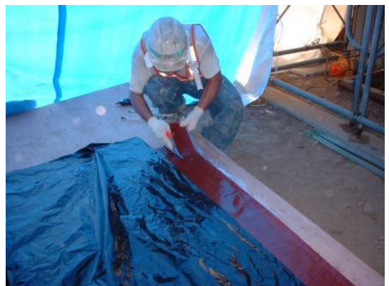
写真－7 上端部用シートの裁断加工
