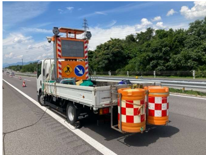
▲車線規制のための保安設備の一例
