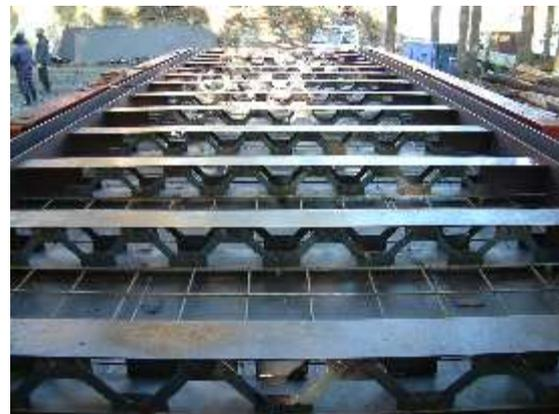
写真-4 トラス支保工設置状況
