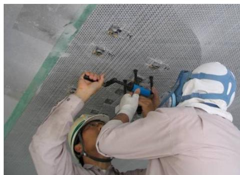
写真-3 付着試験状況
