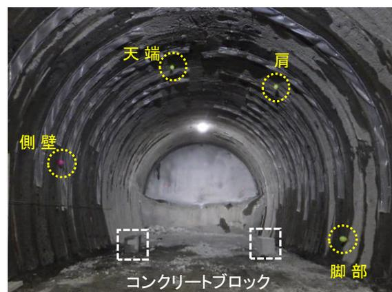
写真-5 ノミ先誘導用目印およびコンクリートブロックの設置状況
