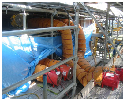
写真-1 エアクーリング実施状況
