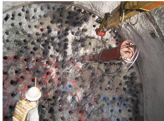
写真-1 割岩掘削状況
