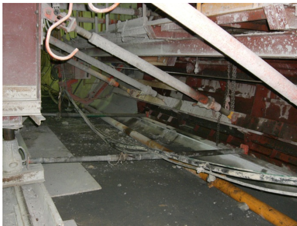
写真-2 セントル下げネコ部補強状況
