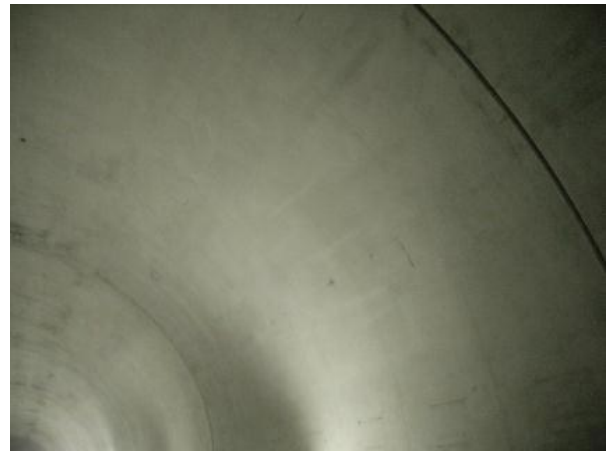
写真-6 トンネル覆工の仕上り状況 (肩部)
