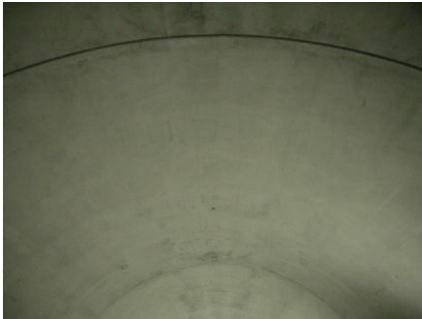
写真-5 トンネル覆工の仕上り状況 (天端部)
