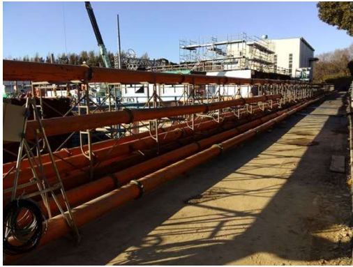
写真-2 検証試験設備(送・排泥配管:400m)
