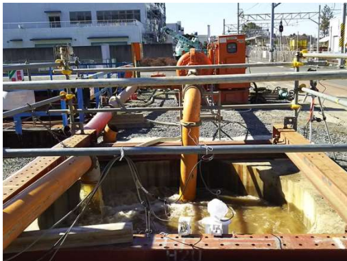
写真-3 検証試験設備(模擬杭孔 φ2,700mm)
