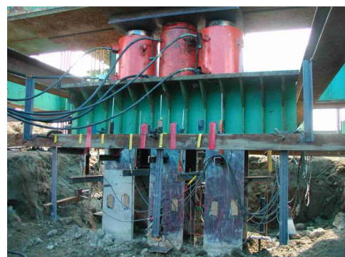
写真－2 鉛直載荷の状況
