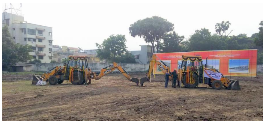
（写真は軌道工事起工式会場）
