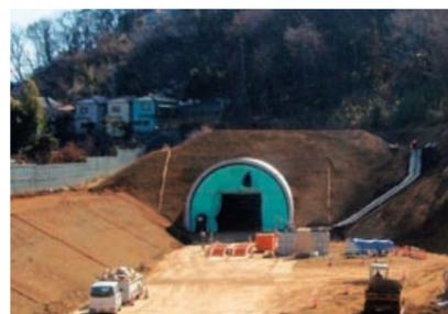
トンネルの両坑口に防音バルーンを設置し騒音を低減
