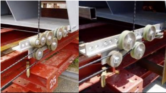
写真－2 プーリー改良
