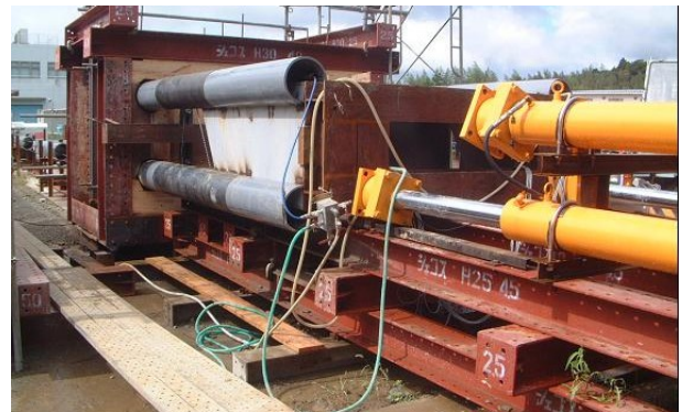
写真-5 土槽切削試験状況（発進側）
