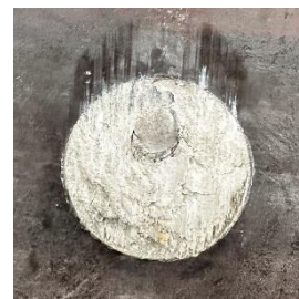
写真－3 試験終了後の接合面の状況(No.1)
