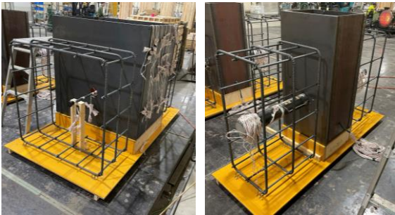
貫通鉄筋 モルタル充填鋼管 写真－２ せん断キー設置状況
