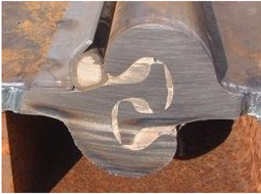
写真-5 充填確認
