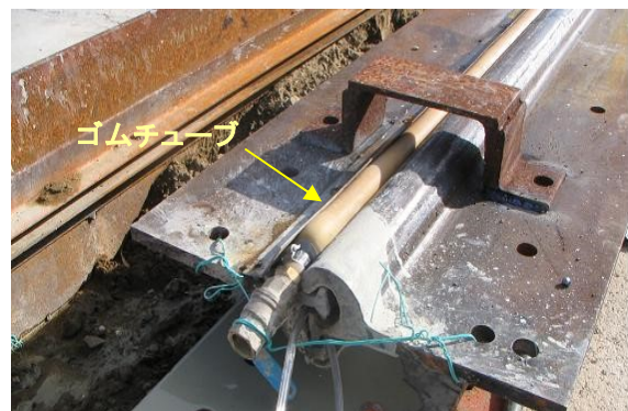
写真-4 ゴムチューブの充填状況
