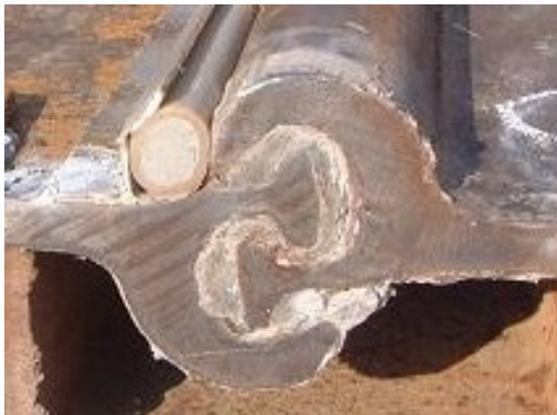
写真-6 充填確認（段差部）
