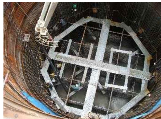
写真-2 大口徑深礎杭の打設状況
