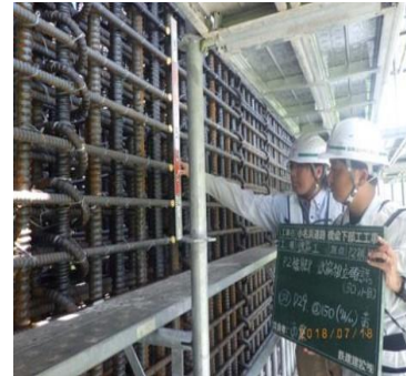
写真－1 従来の鉄筋検査状況
