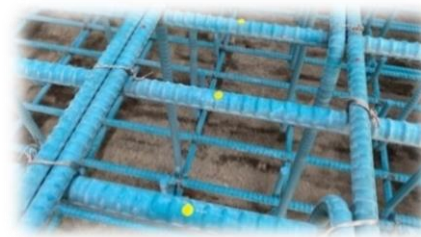
写真－9 計測用マーキング状況
