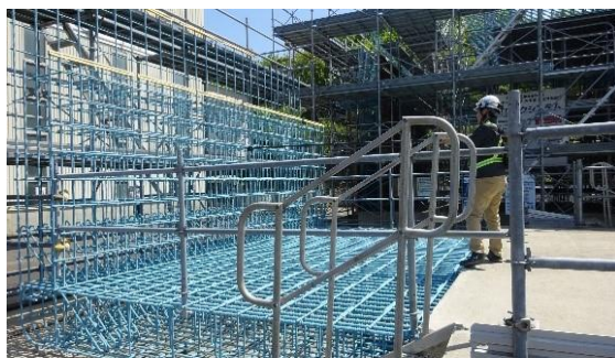
写真－6 SfM処理を用いた点群取得状況
