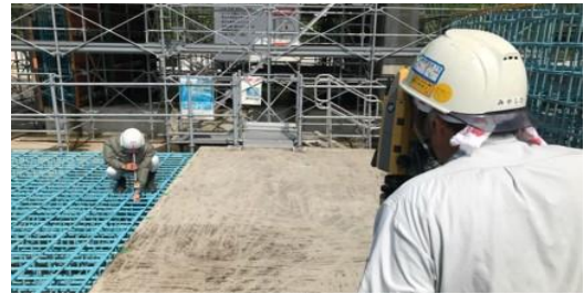
写真－7 TSによる実測値計測状況
