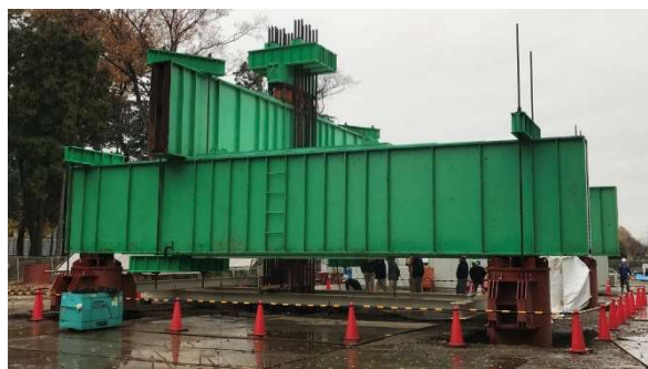
写真-1 載荷試験の実施状況
