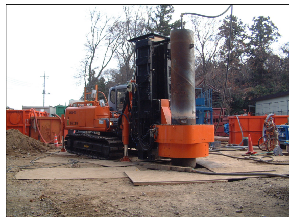
写真－2 施工状況
