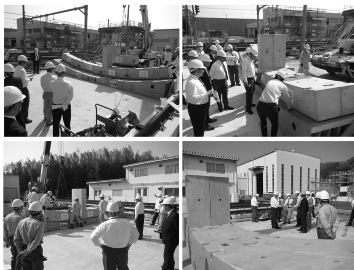
写真-1 プレキャストインバートブロック公開組立て試験状況
