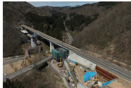
鉄道と道路の交差点の施工例
