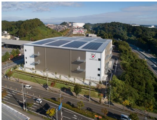
物流施設の施工例
