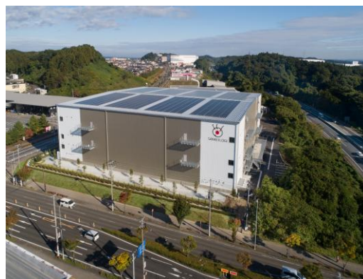
物流施設の施工例
