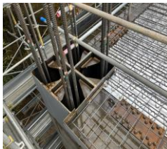
仕口構造の技術開発による大スパン構造実現
