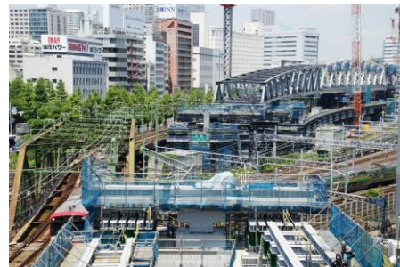
JR線10線をまたぐ京急本線品川・北品川間 八ツ山橋りょう架替
