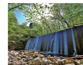
取水口付近の堰堤
